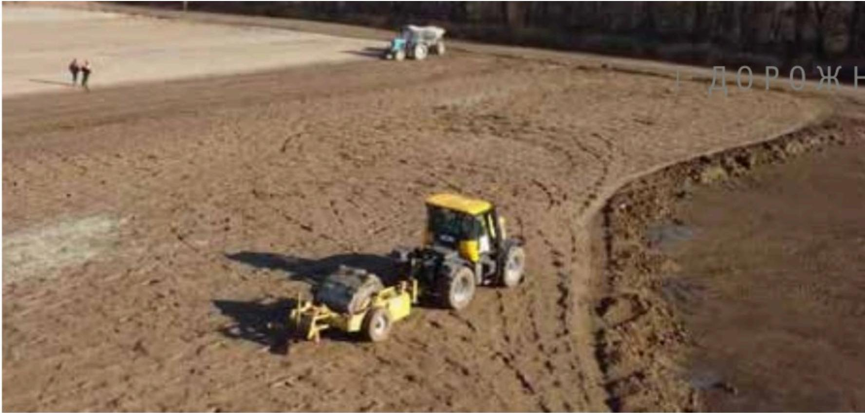
ном – барабаном. Его коренное отличие от обычных прицепных катков в том, что барабан имеет специальную схему подвеса, которая обеспечивает вертикальное перемещение рабочего органа относительно рамы. А система пружин и демпферов усиливает динамическую нагрузку, прикладываемую барабаном к обрабатываемой поверхности.
