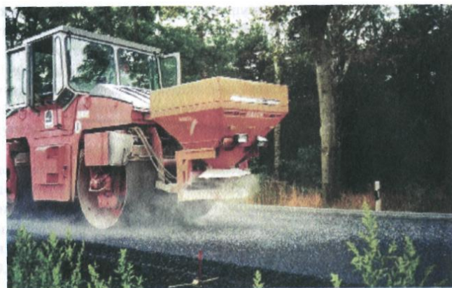
Рис. 52. Распределение высевок перед последним проходом катка
