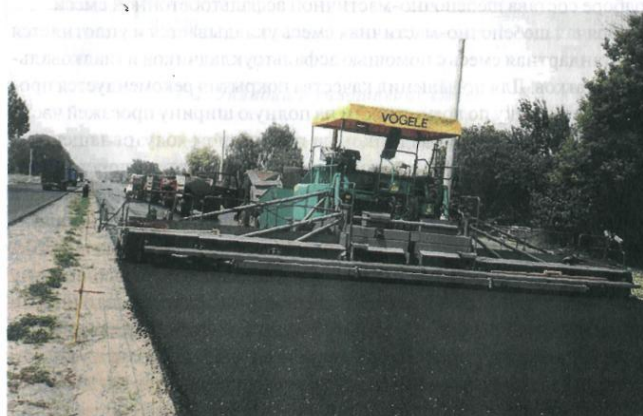
Рис. 21. Укладка смеси широкозахватным асфальтоукладчиком
