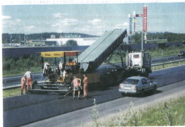
Рис. 25. Укладка ЩМА одним асфальтоукладчиком
