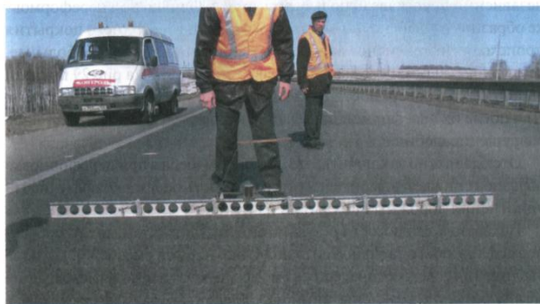
Рис. 28. Контроль ровности и поперечных уклонов покрытия
