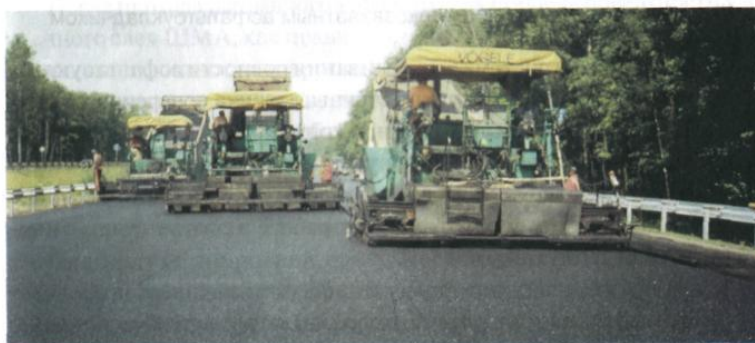
Рис. 20. Укладка смеси на полную ширину проезжей части
