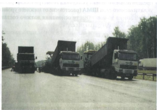
Рис. 22. Загрузка ЦМАС в бункера асфальтоукладчиков
