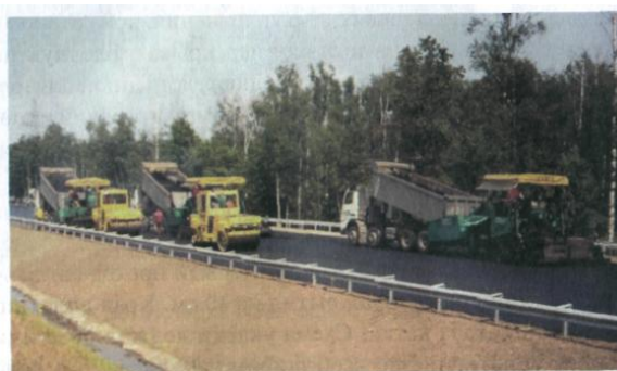
Рис. 24. Устройство покрытия из ЩМА
